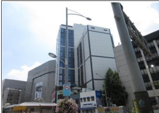
본건전경 (북동측 촬영)
