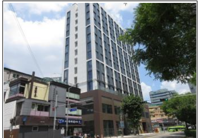
본건전경 (남서측 촬영)
